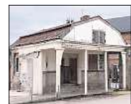
Das Pförtnerhaus bleibt als Kulturdenkmal erhalten.
