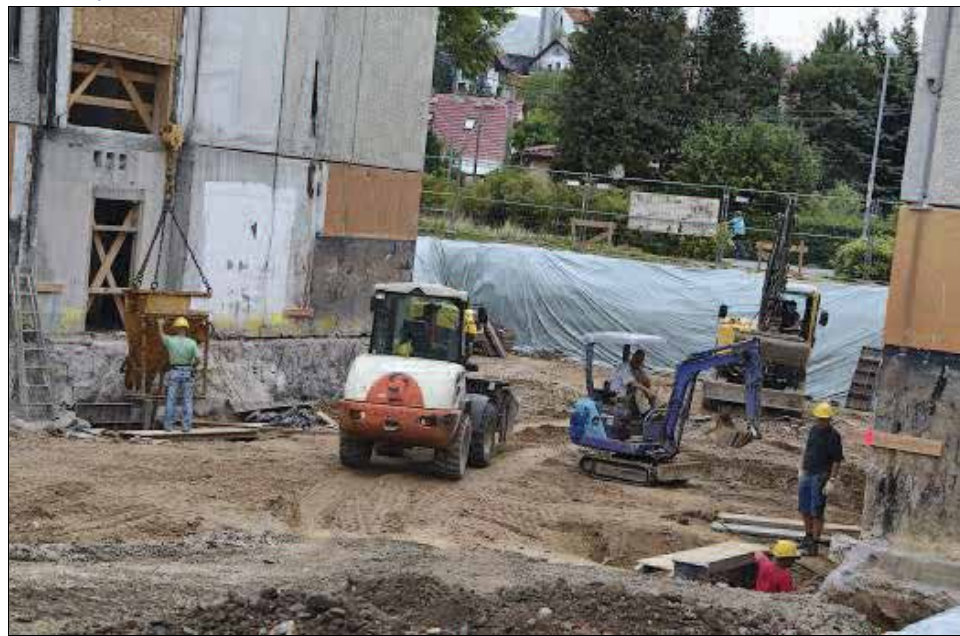
Viel Gewusel herrscht auf der Baustelle des Ernst-Abbe-Gymnasiums: Dort, wo die Bagger gerade die Erde abtragen, wird künftig eine neue Aula stehen, die mit ihren 250 Quadratmetern Platz für alle 870 Schüler hat. Fotos (3): Anne Zeuner
