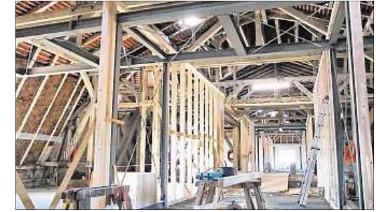
Der imposante Dachstuhl der Westschule wird zurzeit umgestaltet.
