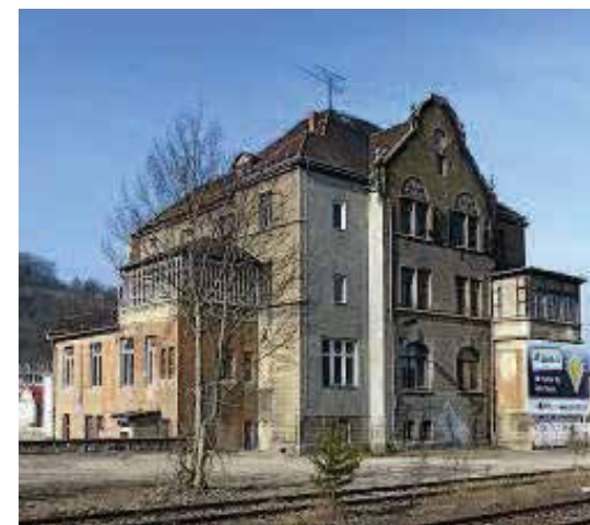
Das nannte man 1897 verkehrsgünstige Lage: Die Prüssing-Villa liegt direkt neben den Gleisen der früheren Anschlussbahn.
