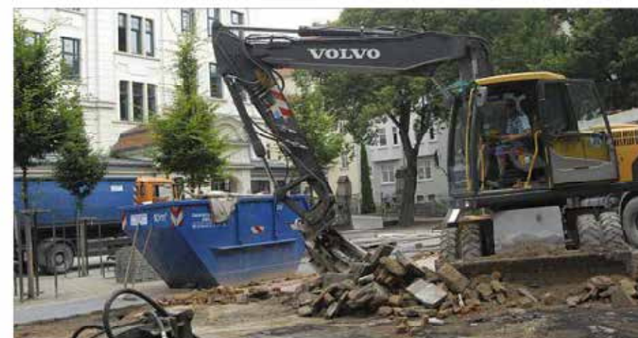
Vom Süden her auf die Westschule geschaut: Der Polytechnikum-Flachbau ist bereits abgerissen. Foto: Thomas Stridde
