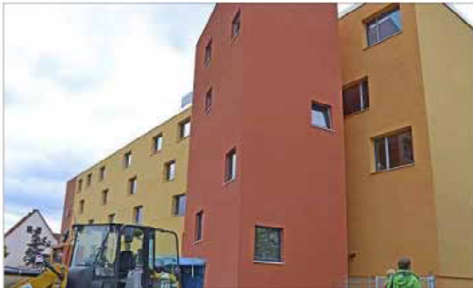
Unübersehbar ist der hohe Anbau an der Rautalschule – der rote rechteckige Turm birgt ein alle Etagen verbindendes Treppenhaus sowie den neu eingebauten Fahrstuhl. Fotos (2): Michael Groß
