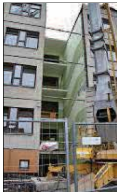
Wo früher eine Treppe war, entsteht nun ein Fahrstuhl.
