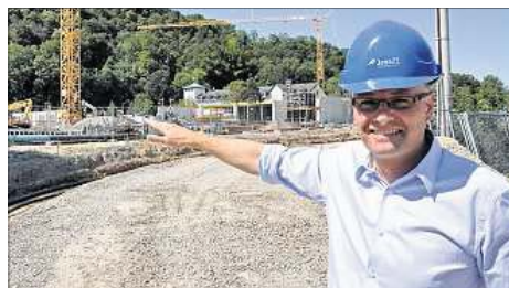
KIJ-Projektleiter Tobias Wolfrum zeigt auf die Baustelle der Lasos GmbH, der ersten Firma, die auf dem Gelände baut. Fotos (2): Lutz Prager
