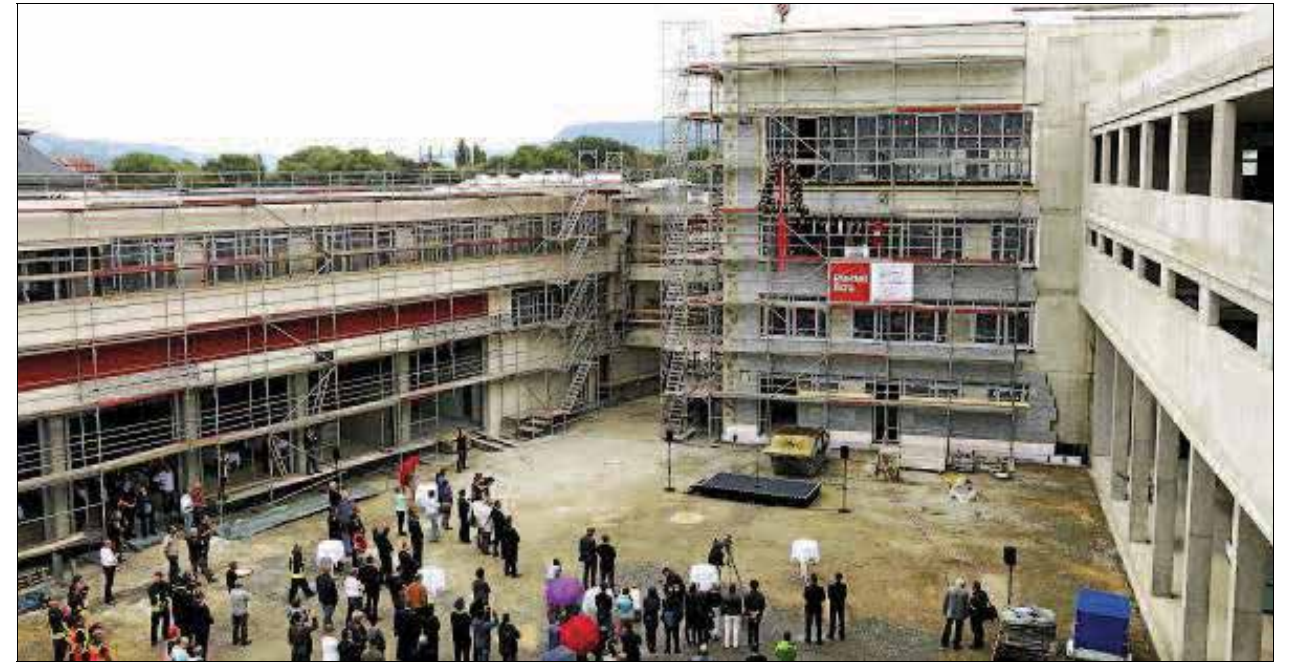
Richtfest im künftigen Alarmhof des Gefahrenabwehrzentrums Am Anger. Vor zahlreichen Gästen und Beschäftigten am Bau verlas Ulrich Landmann, Polier der Rohbau-Firma Riedel-Bau GmbH Erfurt den Richtspruch Foto: Frank Döbert
