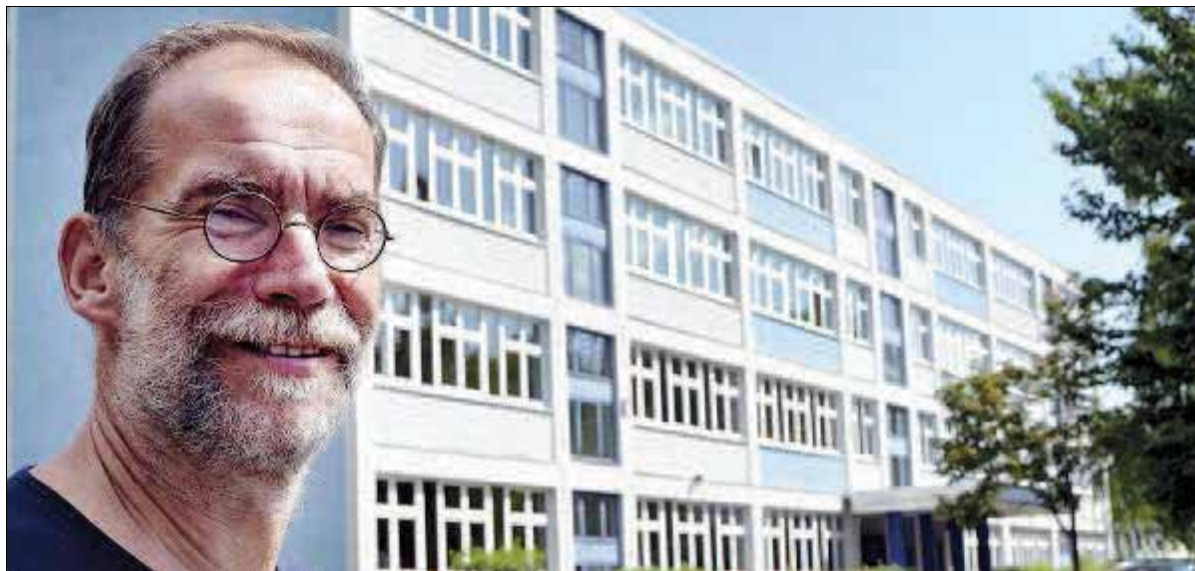
Das ehemalige Otto-Schott-Gymnasium am Ende der Erlanger Allee ist bereit für den Einzug der Stadtrodaer Schüler, dafür hat Benjamin Zollmann gesorgt, der bei den Kommunalen Immobilien Jena für Schul- und Sportimmobilien zuständig ist. Fotos (3): Lutz Prager
