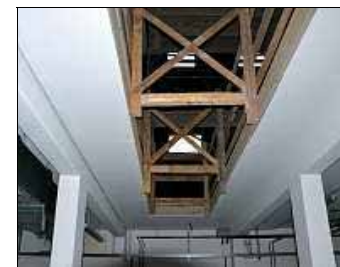
Blick aus dem Keller in die zwei Etagen darüber. Sie sollen die künftige Probebühne aufnehmen.
