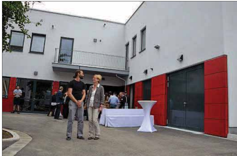
Einweihung des Funktionsanbaus am Jenaer Theaterhaus: Claudia Persch, Projektleiterin bei KIJ, und Mario Müller, technischer Leiter, haben den Bau in den vergangenen zwei Jahren begleitet. Foto: Anne Zeuner
