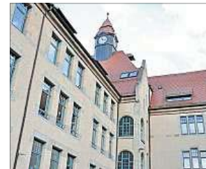
Als Einzeldenkmal ist die Nordschule geschützt.
