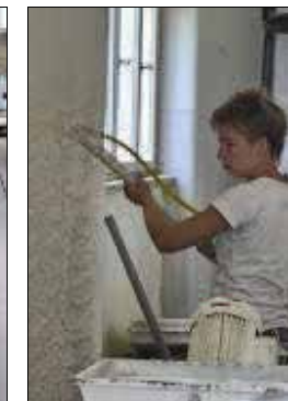
Die Farbe in den Fluren wird aufgespritzt und danach glatt gezogen.
