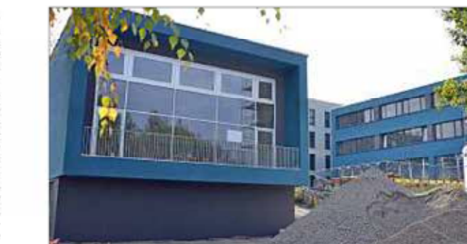
Blick auf die Baustelle zwischen Karl-Marx-Allee und Alfred-Diener-Straße: Gut zu sehen ist schon der neue Baukörper der Aula (links), der sich gut in den Schulkomplex einfügt.
