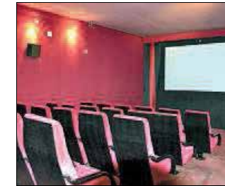
Im 30 Plätze fassenden Roten Kino-Saal des Schillerhofes wurden die Sicherheitsleuchten erneuert.
