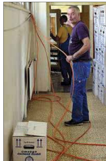
Hanno Niedziolka von einem Bad Köstritzer Elektrobetrieb zieht neue Elektroleitungen ein.
