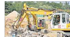
Die Bagger der Jenaer Firma Streicher haben nach wie vor viel zu tun.
