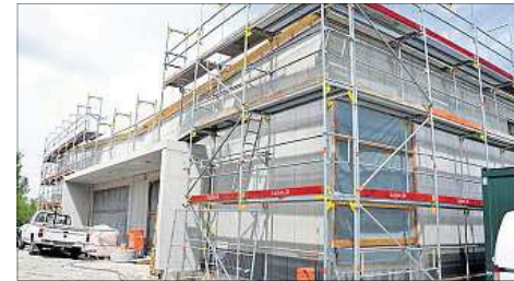
Die neue Aula neben dem künftigen Otto-Schott-Gymnasium steht schon im Rohbau.
