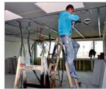
Strippenwirr in einem der künftigen Fachkabinette im Mitteltrakt des Schulstandorts.
