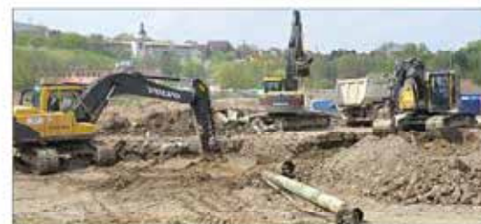
An einigen Stellen des Gewerbegebietes Jena 21 in Göschwitz laufen noch Beräumungsarbeiten. Die Bagger holen u. a. alte Leitungen aus dem Boden. Foto: Lutz Prager
