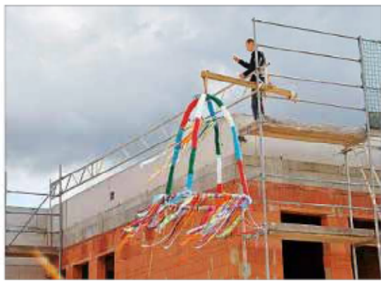
Richtfest: Der Funktionsanbau des Theaterhauses steht. Im September 2014 soll der Bau, in dem Proberräume und Werkstätten untergebracht sind, fertiggestellt werden. Foto: Stefanie Büchtem
