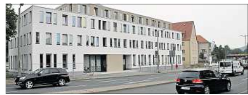
Lutherplatz 3 ist die offizielle Adresse des neuen Gebäudes, obwohl es sich auf der anderen Straßenseite befindet. Foto: Lutz Prager
