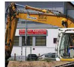
Die Baustelle im Blick: Über die Straße befindet sich die Hauptwache der Feuerwehr. Foto: Frank Döbert
