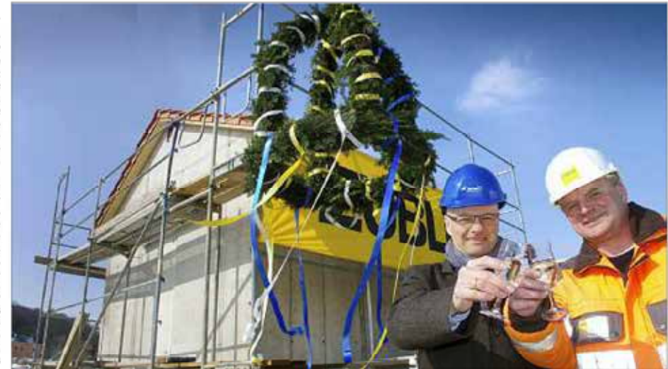
Vor dem Pumpenhaus zum unterirdischen Regenrückhaltebecken: Tobias Wolfrum (l.), Technischer Leiter beim Immobilienbetrieb KIJ, und Joachim Lange, Polier bei der Firma Züblin, stoßen auf ein Bauvorhaben an, das voller Herausforderungen steckt. Foto: Thomas Beier
