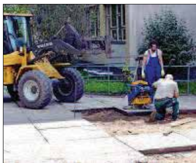
Im hinteren Teil des Schulhofes werden drei Hochbeete für den Schulgarten angelegt.
