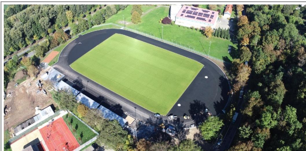
Auf der Drohnenaufnahme sichtbar: Auf die fertige Asphalttragschicht sowie die etwa zur Hälfte fertig gestellte Basisschicht des Kunststoffbelags muss noch die ziegelrote Deckschicht (3mm) aufgebracht werden.
